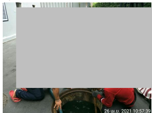
รูปที่ 2-46 ประสานงานกับสำนักงานเขตบางพลัดเข้ามาสูบตะกอนของระบบบำบัดน้ำเสีย
