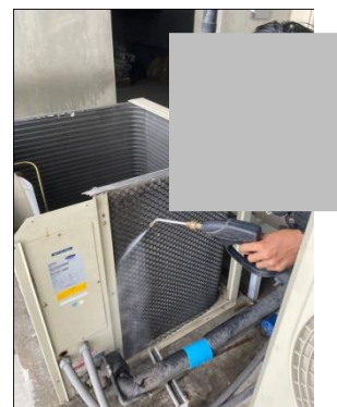
รูปที่ 2-39 ทำความสะอาดแผ่นกรองอากาศส่วนกลาง
