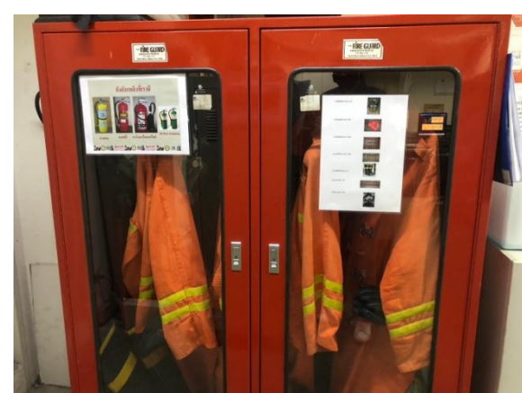
รูปที่ 2-31 ตู้เก็บชุดดับเพลิงและอุปกรณ์
