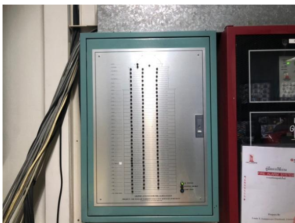
รูปที่ 2-30 ตู้ควบคุมระบบป้องกันอัคคีภัย
