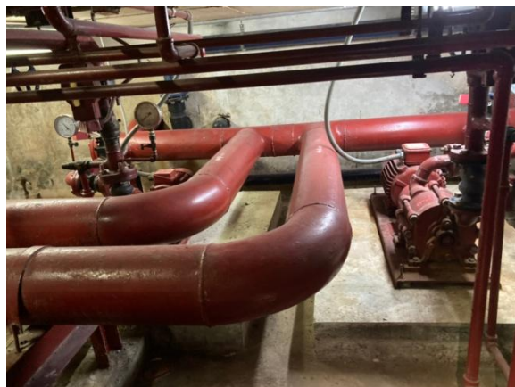
รูปที่ 2-15 เส้นท่อน้ำดับเพลิง
