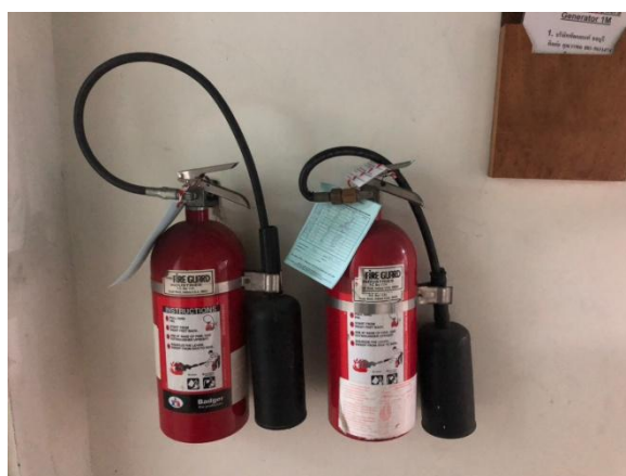
รูปที่ 2-25 ถังดับเพลิงชนิดมือถือและคำแนะนำการใช้
