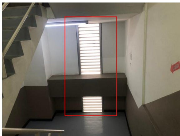
รูปที่ 2-17 ช่องระบายอากาศบริเวณบันไดหนีไฟ
