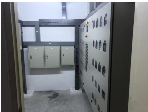
รูปที่ 2-43 มิเตอร์ไฟฟ้าประจำชั้น
