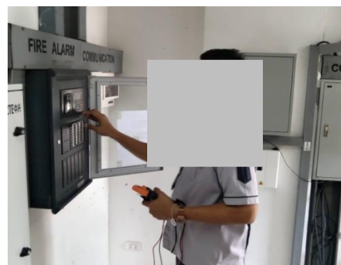
รูปที่ 2-53 การตรวจเช็คระบบป้องกันอัคคีภัย
