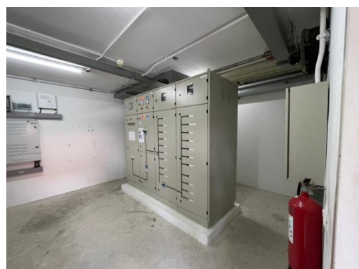
รูปที่ 2-19 แยกมิเตอร์ไฟฟ้าสำหรับระบบบำบัดน้ำเสียออกจากมิเตอร์ไฟฟ้าสำหรับใช้ในอาคาร
