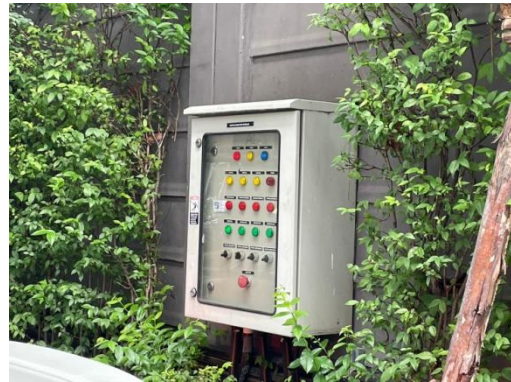
รูปที่ 2-16 ตู้ควบคุมระบบบำบัดน้ำเสีย
