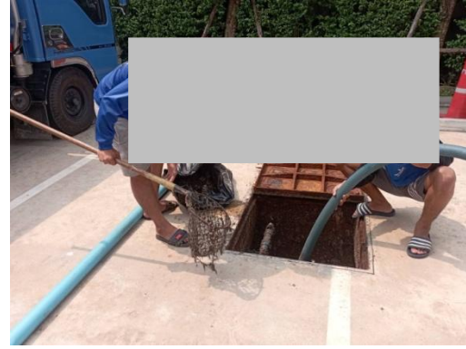
รูปที่ 2-22 ประสานงานผู้รับเหมาเข้ามาสูบกากตะกอนจากระบบบำบัดน้ำเสียของโครงการ
