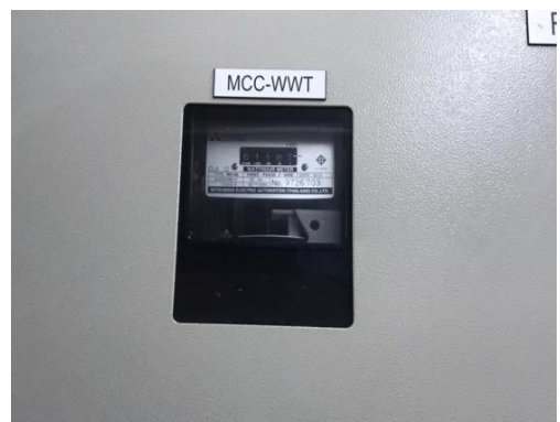
รูปที่ 2-19 แยกมิเตอร์ไฟฟ้าสำหรับระบบบำบัดน้ำเสียออกจากมิเตอร์ไฟฟ้าสำหรับใช้ในอาคาร
