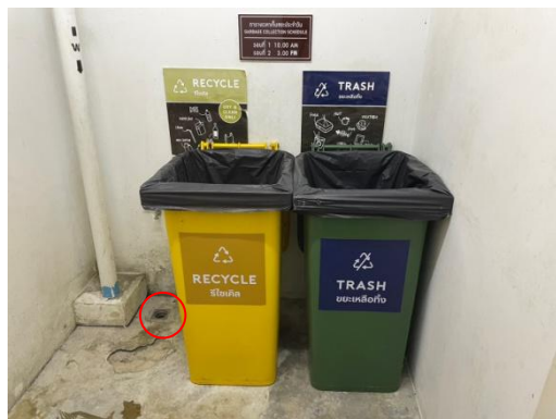
รูปที่ 2-18 ท่อรวบรวมน้ำเสียจากห้องพักขยะประจำชั้น
