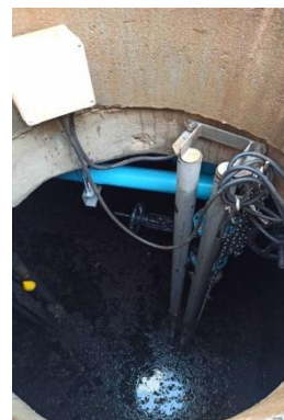
รูปที่ 2-22 การตรวจสอบดูแลและซ่อมบำรุงเครื่องสูบน้ำเสีย และเครื่องเติมอากาศของระบบบำบัดน้ำเสีย
