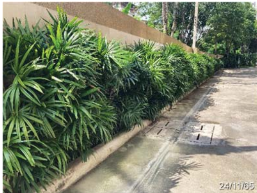
ท่อระบายน้ำและบ่อพักน้ำรอบอาคาร
