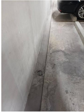
รูปที่ 2-35 จัดให้ชั้นใต้ดินที่ 3-5 มีท่อระบายน้ำเพื่อรวบรวมน้ำฝนไปยังบ่อสูบน้ำ
