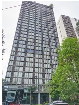
รูปที่ 2-8 กระจกหน้าต่างที่ใช้ ค่าการสะท้อนแสงไม่เกิน ร้อยละ 30
