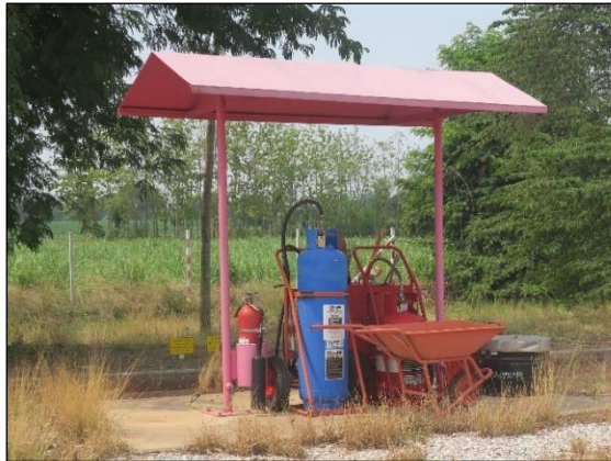
ภาพที่ 2.2-1 อุปกรณ์ดับเพลิงและขจัดครบน้ำมันประจำฐานหลุมผลิตประดู่-เอ (PDA-A)
