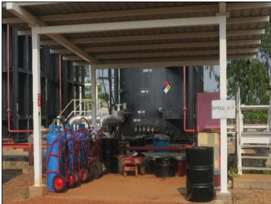
ภาพที่ 2.2-2 อุปกรณ์ดับเพลิงและขจัดครบน้ำมันประจำฐานหลุมผลิตหนองแสง-เอ (NSG-A)
