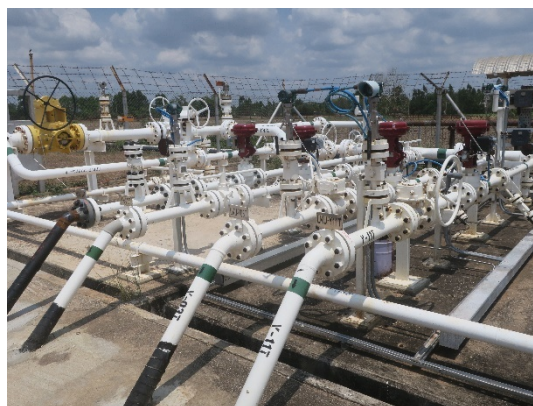
ระบบควบคุมความดันในเส้นท่อ (Manifold)
