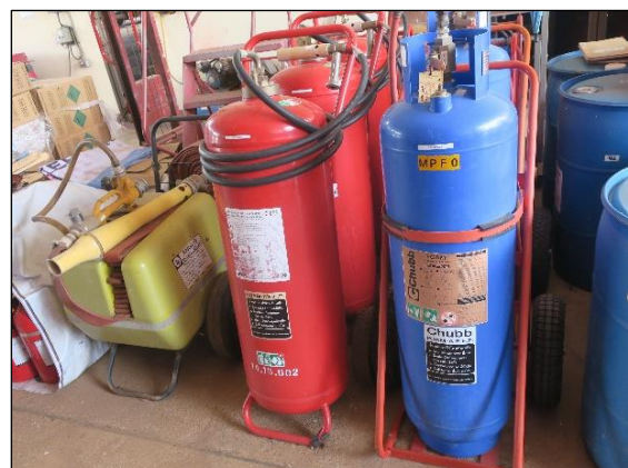
ภาพที่ 2.2-3 อุปกรณ์ดับเพลิงและขจัดครบน้ำมันที่สถานีผลิตลานกระบือ (LKU Flow Station)
