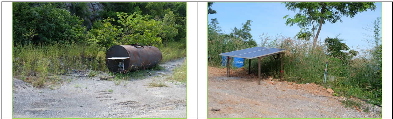
รูปที่ 4 เดินระบบท่อน้ำหยดโดยใช้แผงโซลาร์เซลล์เพื่อฉีดรดต้นไม้บริเวณขอบเหมือง
