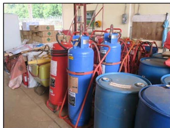
ภาพที่ 2.3-2 อุปกรณ์ป้องกันอัคคีภัยและอุปกรณ์ขจัดคราบน้ำมันที่สถานีผลิตลานกระบือ (F/STN)
