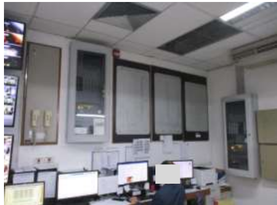
รูปที่ 2-38 แผงวงจรอิเล็กทรอนิกส์ เตือนอัคคีภัย ภายในห้องควบคุม และเฝ้าระวังอัคคีภัยของโรงแรม
