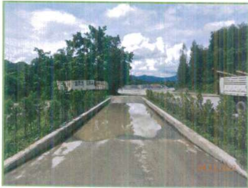
ภาพที่ 2-14 จุดล้างล้อไถบริเวณด้านหน้าของพื้นที่โรงไม้หิน
