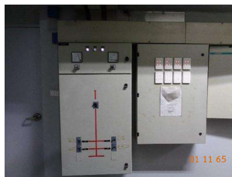
รูปที่ 2-31 อุปกรณ์เปิด-ปิด ระบบแสงสว่างอัตโนมัติ บริเวณพื้นที่สาธารณะของโครงการ
