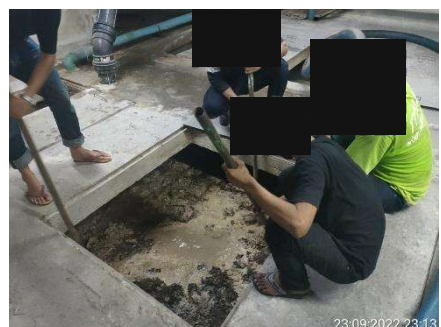
รูปที่ 2-24 การสูบกากตะกอนในถังเกรอะ
