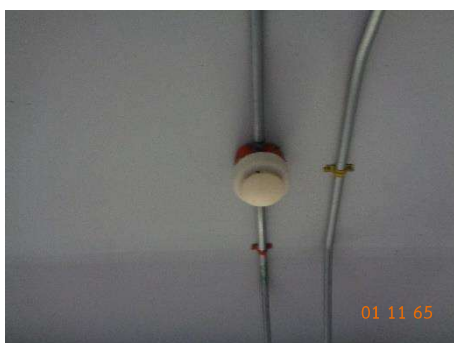
รูปที่ 2-38 อุปกรณ์ตรวจสอบจับความร้อน
