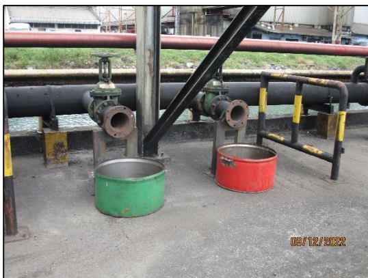
รูปที่ 2-4 ภาพขณะรองรับการรั่วไหลของกากน้ำตาล
