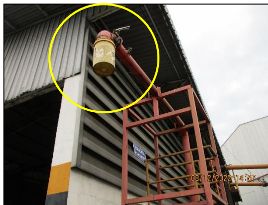
รูปที่ 2-4 ภาพขณะรองรับการรั่วไหลของกากน้ำตาล
