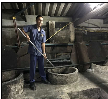
ภาพที่ 2-2 บ่อดักไขมัน , เจ้าหน้าที่ดูแลระบบบำบัดน้ำเสียและดักไขมันออกจากบ่อดักไขมันและถูกดำนบรรจุไขมัน
