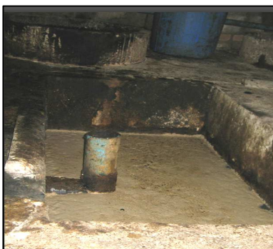
ภาพที่ 2-2 บ่อดักไขมัน , เจ้าหน้าที่ดูแลระบบบำบัดน้ำเสียและดักไขมันออกจากบ่อดักไขมันและถูกดำนบรรจุไขมัน
