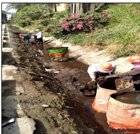
รูปที่ 2-28 การขุดลอกตะกอนดินในคูระบายน้ำของโครงการ
