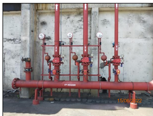
รูปที่ 2-9 อุปกรณ์ระบบดับเพลิง
