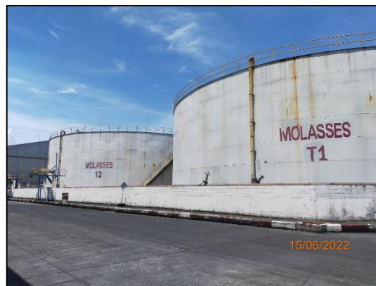
รูปที่ 2-1 คันกันป้องกันการรั่วไหลโดยรอบถังเก็บกากน้ำตาล
