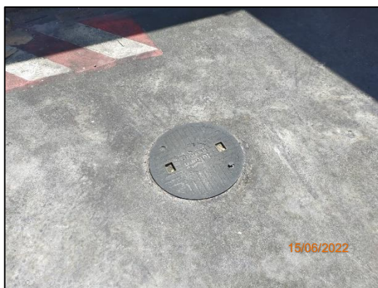
รูปที่ 2-7 บ่อคอนกรีตสำหรับรวบรวมน้ำเสีย
