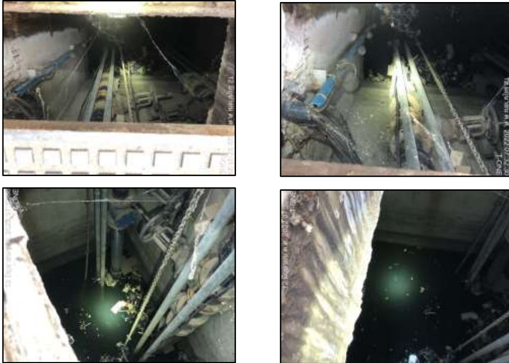
รูปที่ 2-44 เครื่องสูบน้ำเพื่อควบคุมอัตราการระบายน้ำฝนออกจากบ่อหนองน้ำ
