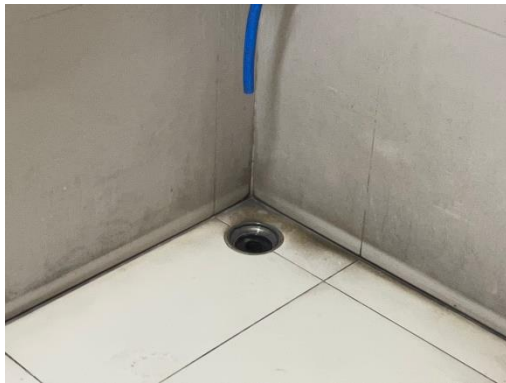
รูปที่ 2-33 ท่อรวบรวมน้ำเสียที่เกิดจากการล้างห้องพัสดุฝอยรวมเข้าสู่ระบบบำบัดน้ำเสีย
