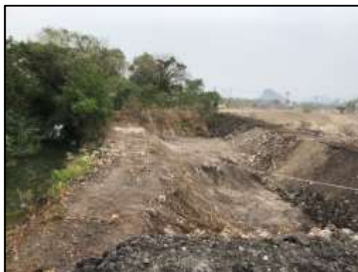
รูปที่ 2-9 ปอดักตะกอนภายในพื้นที่โครงการ
