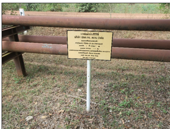
ภาพที่ 2.2-2 ป้ายเตือนสะท้อนแสง แสดงตำแหน่งแนววางท่อ
