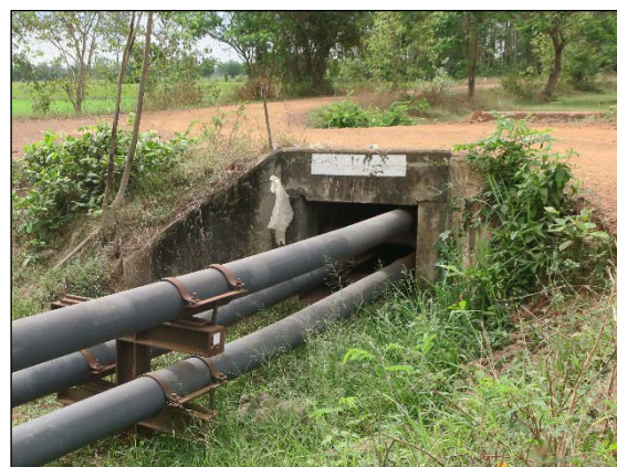
ภาพที่ 2.2-3 ทางข้ามแนวท่อ (Pipe Crossing)
