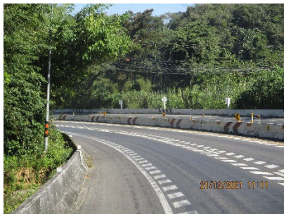
เส้น Optical speed Bar Rumble Strips บริเวณ กม.357+250 (เดิม กม.137+276)
