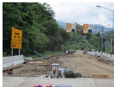
บริเวณที่อยู่ระหว่างปรับปรุงผิวทางเป็นคอนกรีตเสริมเหล็ก
