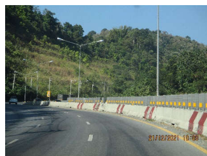
แผงกันแสงไฟหน้ารถบริเวณ เกาะกลางแบบ Concrete Barrier บริเวณ กม.350+125 (เดิม กม.130+131)
