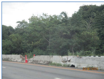
การชำรุดของ Concrete Barrier บริเวณ กม.357+500 (เดิม กม.137+527)
