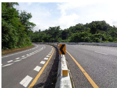
สภาพผิวจราจร และเส้น Optical speed Bar Rumble Strips กม.360+100 (เดิม กม.140+178)
