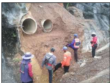
ภาพที่ 5.2.6-2 การซ่อมแซมอาคารระบายน้ำที่ บริเวณ กม.1131+800 (ด้านพัทลุง-ตรัง)
