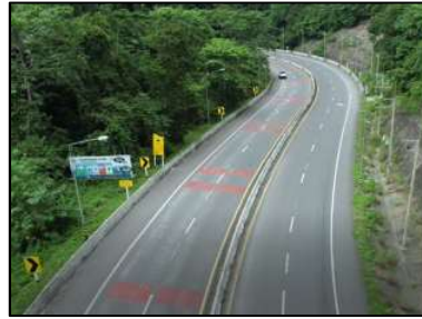
Red Anti Skid กม.1133+800 (เดิม กม.41+840) ด้านตรัง-พัทลุง
