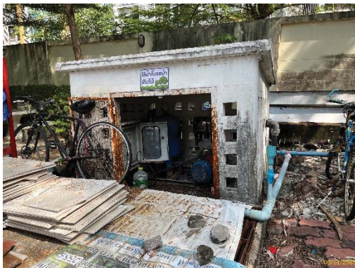
บ่อพร้อมปั๊มสูบน้ำทิ้งรดน้ำต้นไม้
