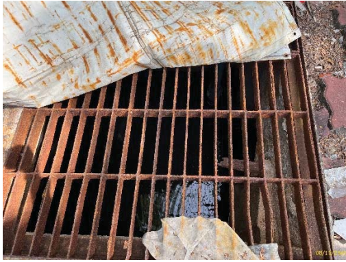
บ่อพักน้ำสุดท้ายก่อนการระบายออกนอกโครงการ
