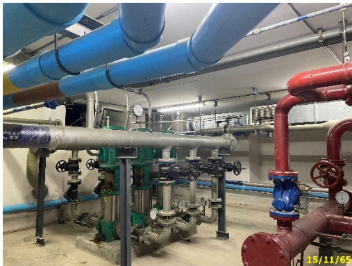
ถังเก็บน้ำ และเครื่องสูบน้ำดับเพลิง ชั้นใต้ดิน
