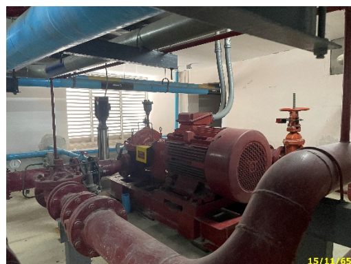
ถังเก็บน้ำ และเครื่องสูบน้ำดับเพลิง ชั้น 19
