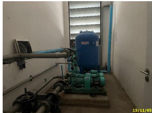
Booster Pump ห้องเครื่องลิฟต์ ชั้นตาดฟ้า
