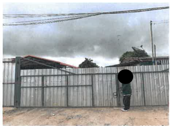
รูปที่ 2-12 แสดงติดตั้งประตู Metal Sheet บริเวณทางเข้า-ออกพื้นที่ก่อสร้าง
