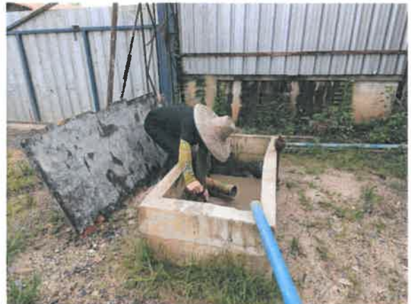
รูปที่ 2-25 แสดงติดตั้งท่อระบายน้ำ สำหรับรวบรวมน้ำเข้าสู่บ่อพัก พร้อมทั้งจัดเจ้าหน้าที่ขุดลอกตะกอนดิน ที่สะสมในบ่อพัก
