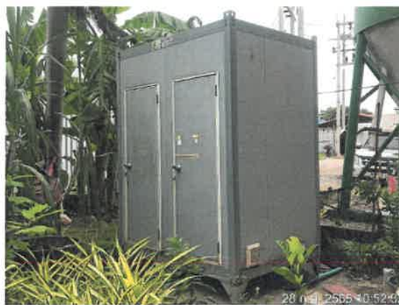
รูปที่ 2-21 แสดงห้องส้วมที่มีระบบบำบัดน้ำเสียสำเร็จรูปแบบถังเกรอะ-กรองไร้อากาศ
