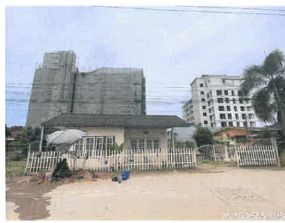
รูปที่ 2-9 แสดงติดตั้ง Mesh Sheet คลุมอาคาร B
