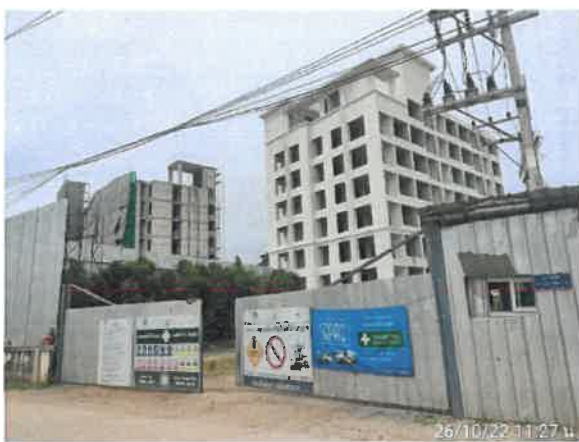
รูปที่ 2-12 แสดงติดตั้งประตู Metal Sheet บริเวณทางเข้า-ออกพื้นที่ก่อสร้าง
