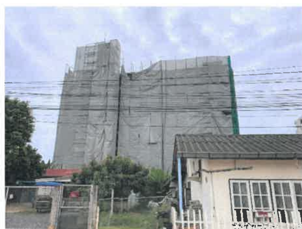
รูปที่ 2-9 แสดงติดตั้ง Mesh Sheet คลุมอาคาร B
