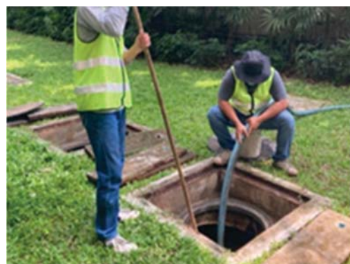
การตักไขมันออกจากระบบบำบัดน้ำเสีย
