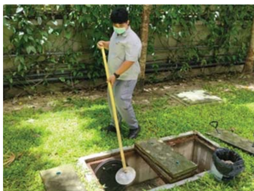
การตักไขมันออกจากระบบบำบัดน้ำเสีย
