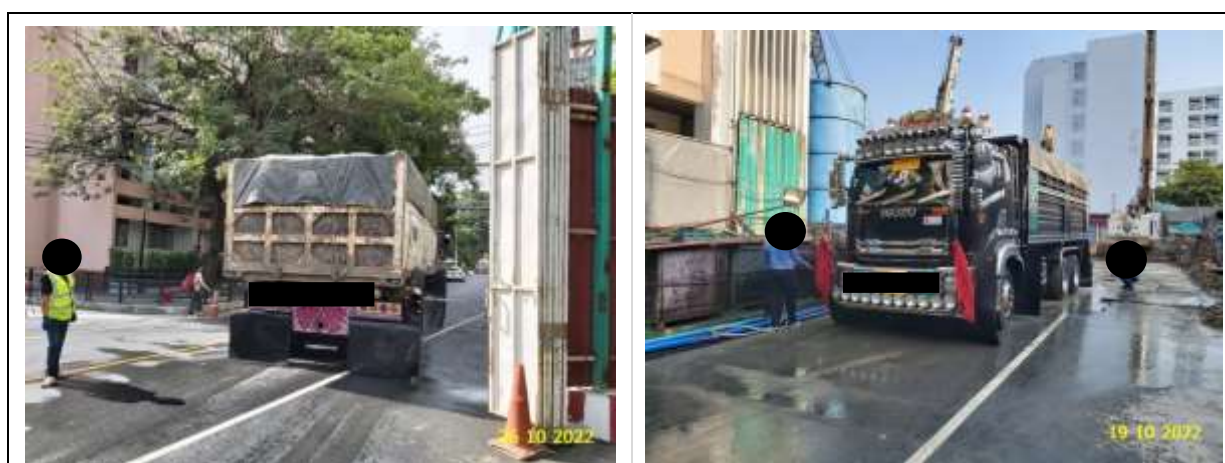
รูปที่ 2-40 แสดงติดตั้งแผ่นป้ายสะท้อนแสงและธงสีบริเวณท้ายรถขนส่งดิน และวัสดุก่อสร้าง
