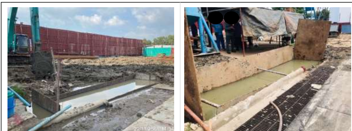
รูปที่ 2-5 แสดงการติดตั้งท่อระบายน้ำ และเครื่องสูบน้ำ สำหรับรวบรวมน้ำเข้าสู่บ่อพัก
