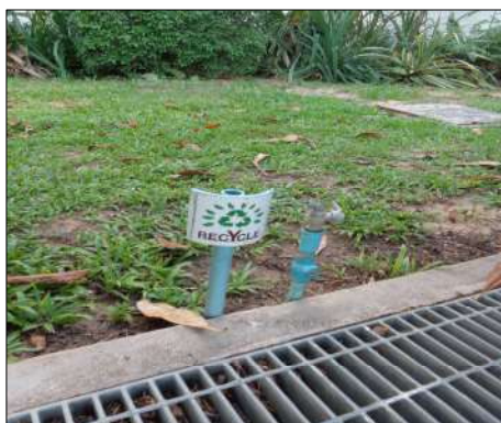
ภาพที่ 1-6 น้ำที่ผ่านระบบบำบัดน้ำเสียโดยนำไปรดน้ำต้นไม้
