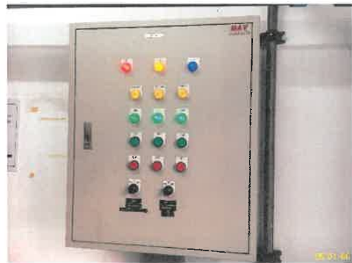
ตู้ควบคุมการทำงานของน้ำเสีย ระบบบำบัดน้ำเสียอาคาร A (ต่อ) ภาพที่ 2.2-7 (ต่อ) ระบบบำบัดน้ำเสียโครงการ
