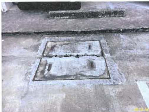
รางระบายน้ำฝนรอบโครงการ ภาพที่ 2.2-16 การระบายน้ำของโครงการ
