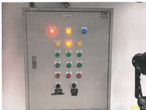
ตู้ควบคุมการทำงานของน้ำเสีย ระบบบำบัดน้ำเสียอาคาร A (ต่อ) ภาพที่ 2.2-7 (ต่อ) ระบบบำบัดน้ำเสียโครงการ
