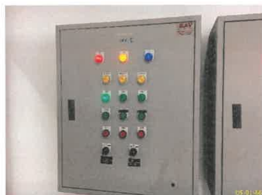
ตู้ควบคุมการทำงานของน้ำเสีย ระบบบำบัดน้ำเสียอาคาร B (ต่อ) ภาพที่ 1.3.5-1 (ต่อ) ระบบบำบัดน้ำเสียโครงการ
