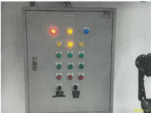
ตู้ควบคุมการทำงานของน้ำเสีย ระบบบำบัดน้ำเสียอาคาร A (ต่อ)
