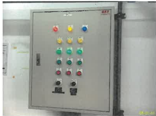
ตู้ควบคุมการทำงานของน้ำเสีย ระบบบำบัดน้ำเสียอาคาร A (ต่อ)
