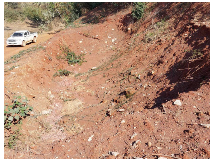
รูปที่ 2-8: บ่อดักตะกอน และบ่อน้ำใส ในสถานที่ทิ้งดินหรือเก็บมูลดินทรายใบอนุญาตที่ 1/2562
