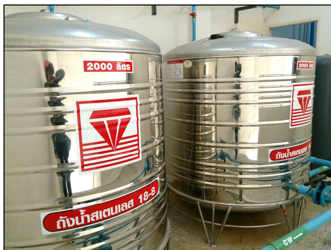
ภาพที่ 1-4 ถังเก็บน้ำสำรองของโครงการ
