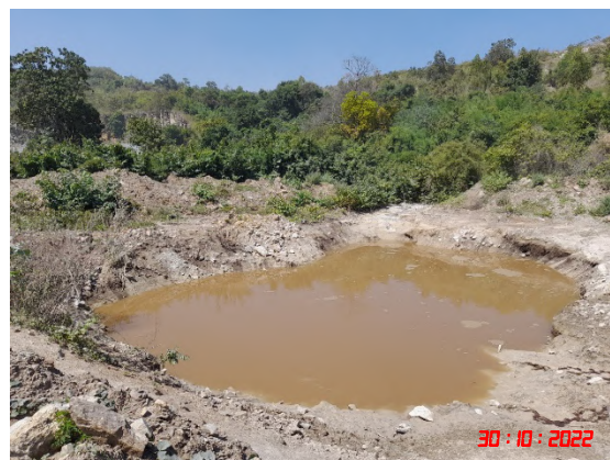
บ่อดักตะกอนบริเวณเหมุดหลักฐานที่ 4
