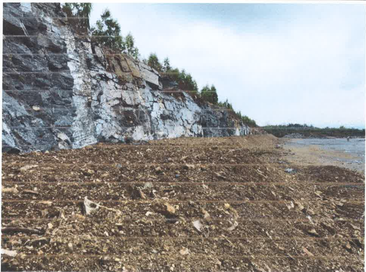
ภาพที่ ๔ : การนำเปลือกดินและเศษหินในบริเวณพื้นที่โครงการมาทำคันดินสำหรับปลูกต้นไม้
