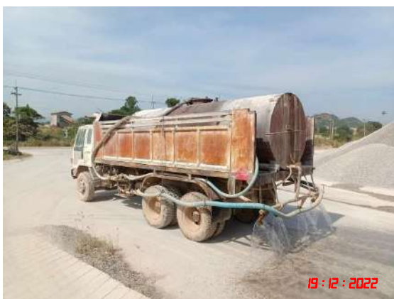
รูปที่ 12 การฉีดพรมน้ำเพื่อลดผลกระทบด้านฝุ่นละออง
