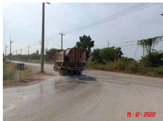
รูปที่ 12 การฉีดพรมน้ำเพื่อลดผลกระทบด้านฝุ่นละออง
