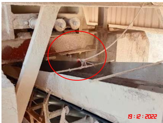
ระบบสเปรย์น้ำบริเวณจุดกำเนิดฝุ่นละออง
