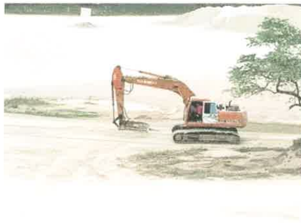
รูปที่ 4 เครื่องแทรกหินแทนการระเบิดรอบสอง เพื่อความปลอดภัยในการระเบิด
