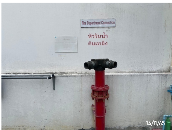
หัวรับน้ำดับเพลิง (Fire Departmentb Conector : FDC)
