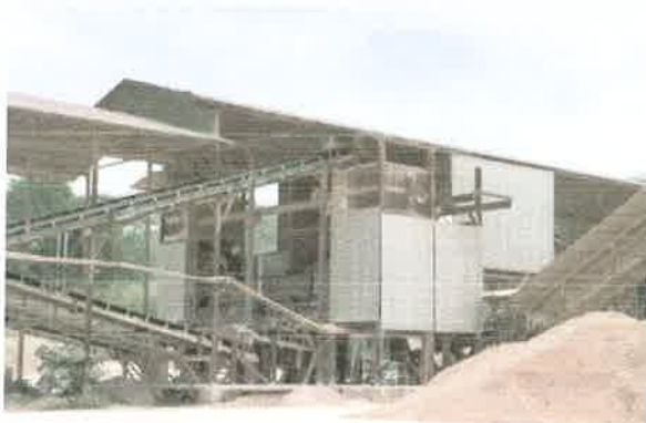
รูปที่ 14 การปิดคลุมอาคารโรงไม้หิน ชุด Secondary และ Tertiary Crusher
