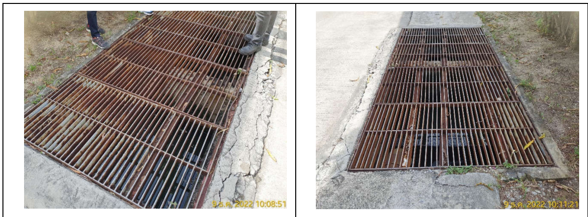
รูปถ่ายที่ 3.2-8 : บ่อและตะแกรงดักขยะ
