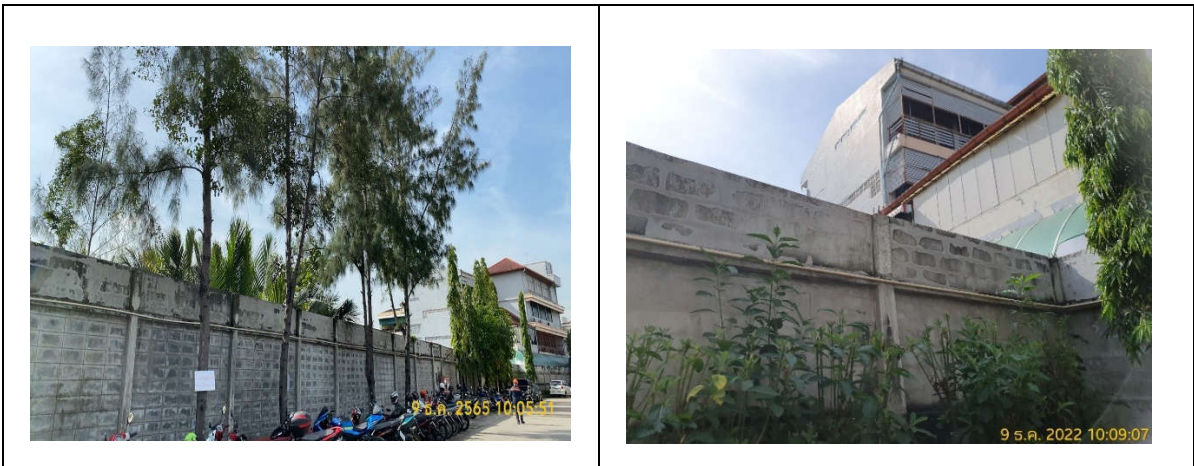
รูปถ่ายที่ 3.2-1 : กำแพงดูดซับเสียง สูง 3 เมตร ติดกับโรงเรียนศิริวิทยา
