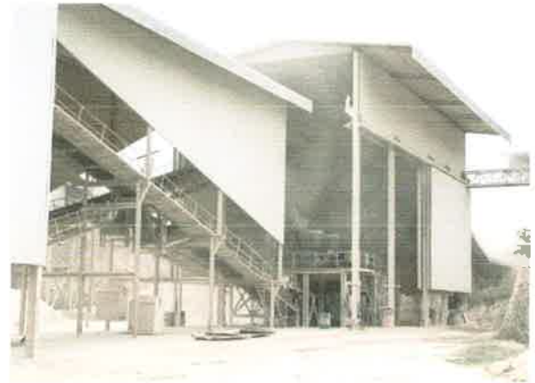
รูปที่ 16 การปิดคลุมอาคารโรงโม่หิน ชุด Secondary & Tertiary Crusher
