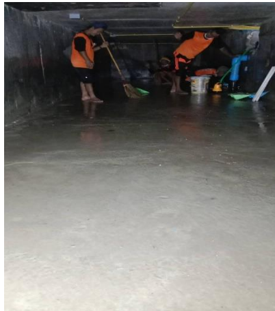
การล้างถังเก็บน้ำชั้นดาดฟ้า
