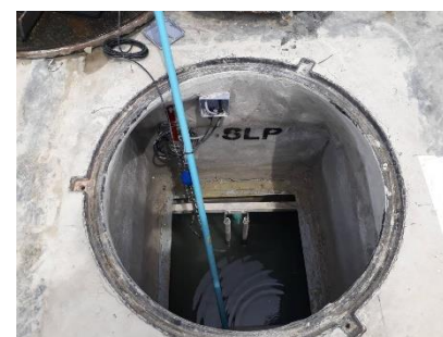
การตรวจสอบปั๊มเครื่องสูบน้ำ
