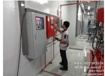
การตรวจเช็คระบบป้องกันและเตือนอัคคีภัย
