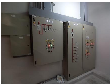
ตู้ควบคุม Transfer Pump
