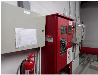
ตู้ควบคุมเครื่องสูบน้ำดับเพลิง
