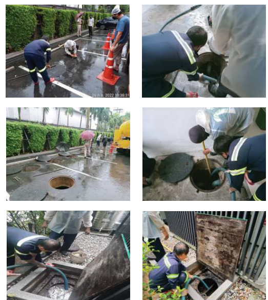
การสูบลบและสิ่งปฏิกูลจากระบบบำบัดน้ำเสีย
