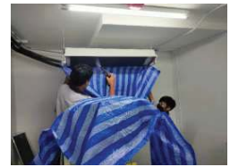
การล้างทำความสะอาดเครื่องปรับอากาศ (ต่อ)
