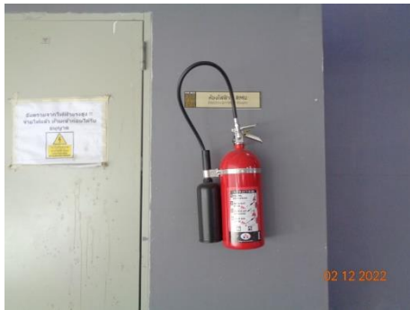
ภาพที่ 2.2-30 การติดตั้งถังดับเพลิงและป้าย แนะนำวิธีใช้ถังดับเพลิง
