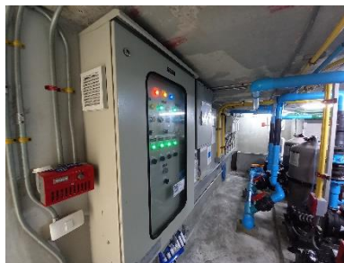
ตู้ควบคุม Transfer Pump
