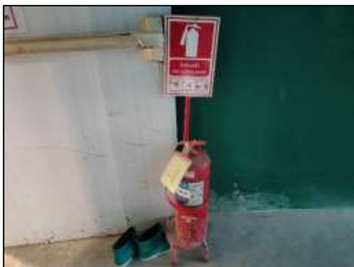
ภาพที่ 47 ถังดับเพลิงและป้ายแนะนำการใช้งาน
