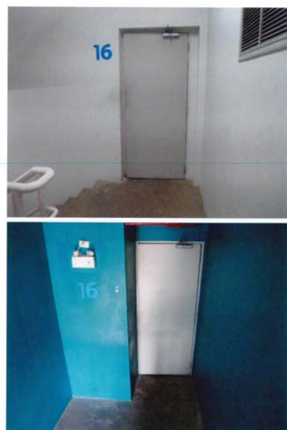
ตรวจสอบ/วางแผนการอพยพและเข้าช่วยเหลือให้ชัดเจน เนื่องจากประตูบันไดหนีไฟไม่สามารถเปิดกลับเข้าตัวอาคารได้
