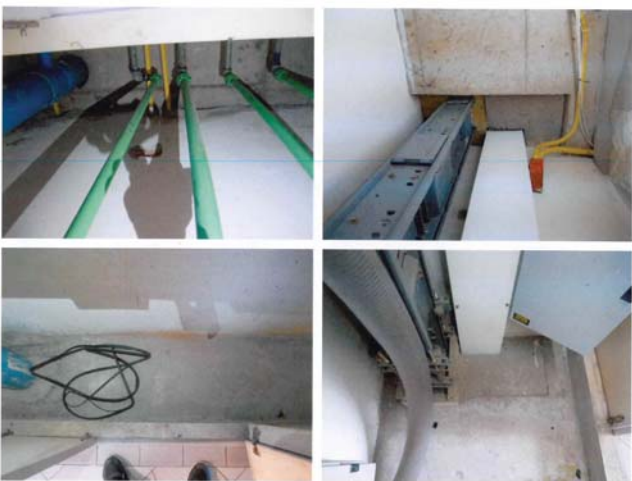
ภาพการปิดช่องเปิดระหว่างชั้น (ซาร์ปงานระบบ) ป้องกันการแพร่กระจายควันไฟ
