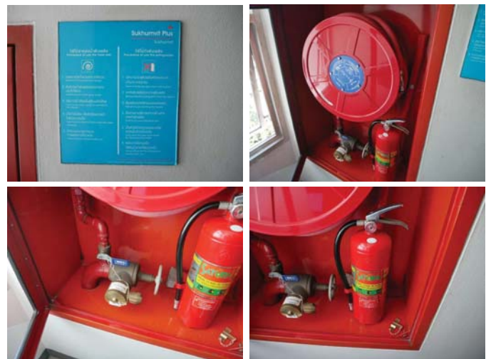
ภาพตู้ FHC สายฉีดน้ำดับเพลิง และถังดับเพลิง มีการตรวจสอบเบื้องต้นจากทางฝ่ายอาคาร
