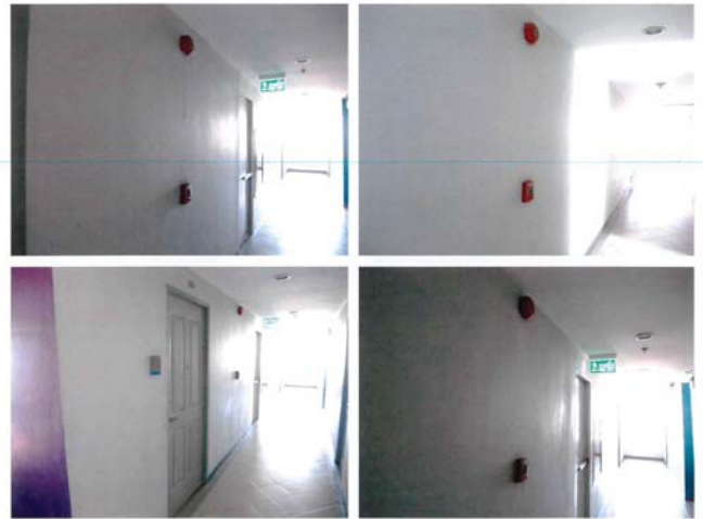
ภาพระบบสัญญาณแจ้งเหตุเพลิงไหม้ด้วยมือและกระดิ่งแจ้งเหตุ มีการตรวจสอบเบื้องต้นจากทางฝ่ายอาคาร
