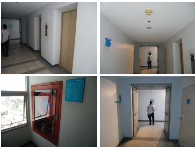
ภาพลิฟต์ดับเพลิง มีพื้นที่ไม่น้อยกว่า 6 ตารางเมตร สามารถจอดได้ทุกชั้น เป็นพื้นที่ปลอดภัยและเปลวไฟ ไม่มีสิ่งกีดขวาง และเป็นที่ตั้งของตู้หัวฉีดดับเพลิงประจำชั้นของอาคาร
