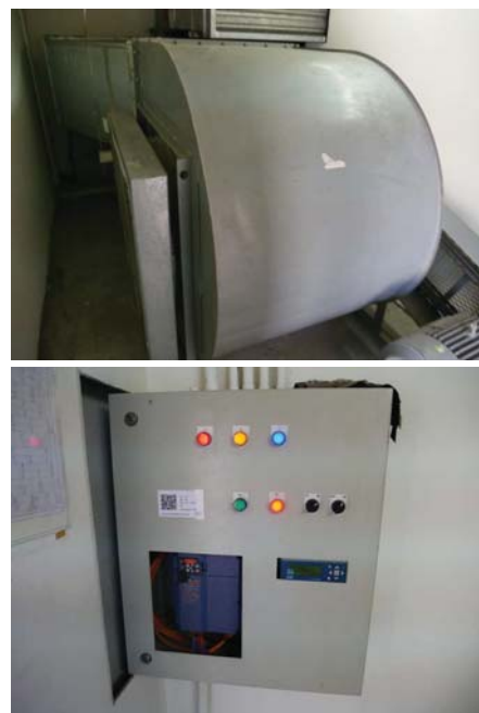
ภาพระบบพัดลมอัดอากาศและอุปกรณ์ประกอบ มีการตรวจสอบและดูแลจากช่างอาคาร
