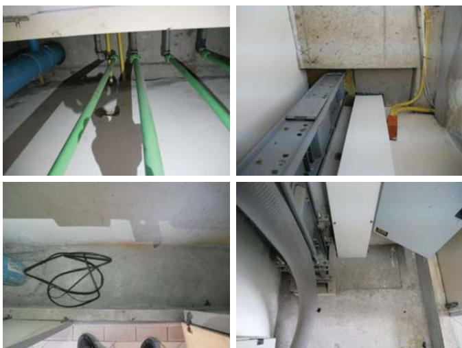
ภาพการปิดช่องเปิดระหว่างชั้น (ขารับงานระบบ) ป้องกันการแพร่กระจายควันไฟ
