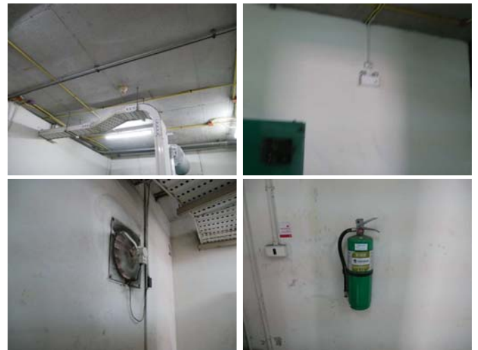
ภาพอุปกรณ์ประกอบห้องระบบไฟฟ้าสำรองฉุกเฉิน
