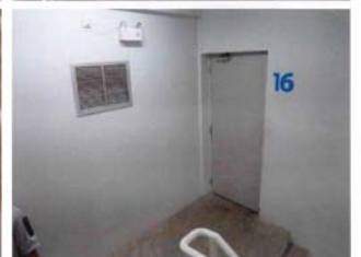
ภาพบันไดหนีไฟและเส้นทางหนีไฟ มีระบบแสงสว่าง ไม่มีสิ่งกีดขวาง ผนังหรือประตูทำด้วยวัสดุทนไฟ สามารถใช้หนีไฟในกรณีฉุกเฉินได้
