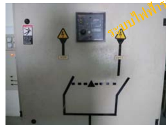
ภาพระบบไฟฟ้าสำรองจ่ายพลังงานไฟฟ้าให้ระบบสำคัญของอาคาร ลิฟต์ดับเพลิง เครื่องสูบน้ำดับเพลิง และพัดลมอัดอากาศเมื่อเกิดเหตุฉุกเฉิน
