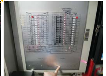
ภาพระบบสัญญาณแจ้งเหตุเพลิงไหม้ ตู้ FCP และ Graphic Annunciator มีการตรวจสอบเบื้องต้นจากทางฝ่ายอาคาร
