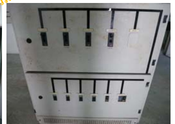
ภาพระบบไฟฟ้าสำรองจ่ายพลังงานไฟฟ้าให้ระบบสำคัญของอาคาร ลิฟต์ดับเพลิง เครื่องสูบน้ำดับเพลิง และพัดลมอัดอากาศเมื่อเกิดเหตุฉุกเฉิน
