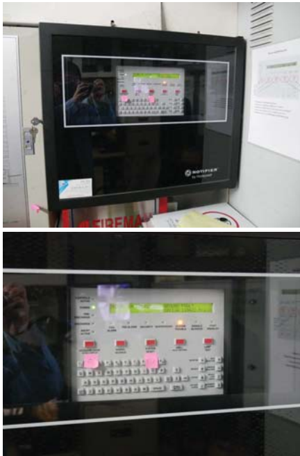
ตรวจสอบและแก้ไขระบบแจ้งเหตุเพลิงไหม้ให้พร้อมใช้งานทุกจุด (ขึ้นสถานะ Trouble)
