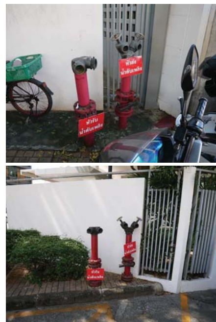
ตรวจสอบและพิจารณาติดตั้งอุปกรณ์ห้วงน้ำดับเพลิงให้ครบทุกจุด
