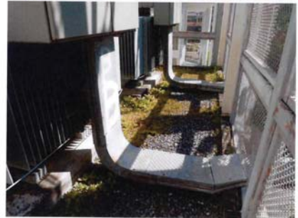
ตรวจสอบและดูแลพื้นที่โดยรอบบริเวณหม้อแปลงไม่ให้มีต้นไม้และสิ่งกีดขวางการทำงาน
