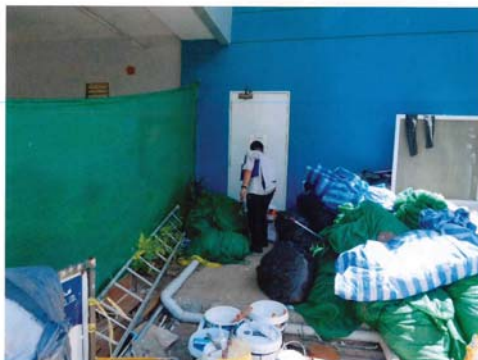
ตรวจสอบและวางแผนแก้ไขพื้นที่บริเวณทางออกสุดท้ายชั้น โคหนิไฟและเส้นทางหนีไฟให้ไม่มีสิ่งกีดขวาง เนื่องจากอาจเป็นอุปสรรคต่อการอพยพเมื่อเกิดเหตุฉุกเฉิน
