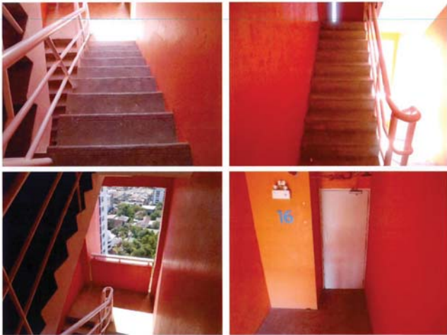
ภาพบันไดหนีไฟและเส้นทางหนีไฟ มีระบบแสงสว่าง ไม่มีสิ่งกีดขวาง หมิงหรือประตูทำด้วยวัสดุทนไฟ สามารถใช้หนีภัยในกรณีฉุกเฉินได้
