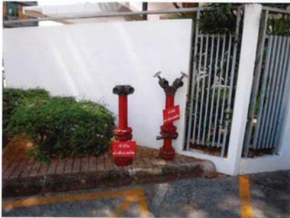
ตรวจสอบและพิจารณาติดตั้งฝารอบหัวรับน้ำดับเพลิงให้ครบทุกจุด
