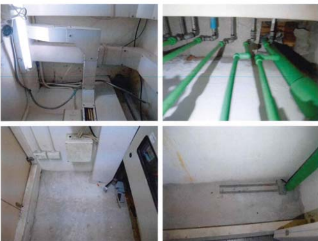
ภาพการปิดช่องเปิดระหว่างชั้น (จารีปงานระบบ) ป้องกันการแพร่กระจายควันไฟ
