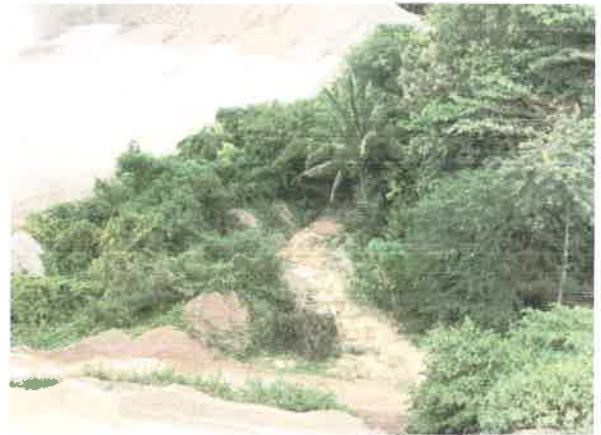
รูปที่ 16 บ่อตกตะกอนดินรองรับน้ำขุนชั้นที่เกิดจากการชะล้างบริเวณที่เก็บกองแร่
