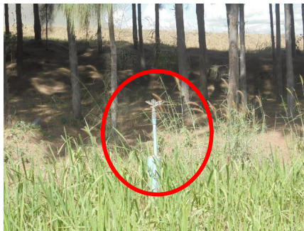
รูปที่ 2-16: ระบบสเปรย์น้ำของโรงโม่หิน
