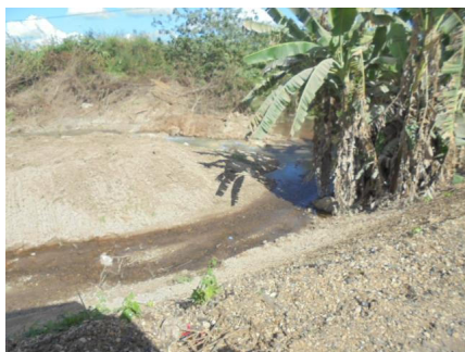
รูปที่ 2-3: คูระบายน้ำรอบพื้นที่กองเปลือกดิน
