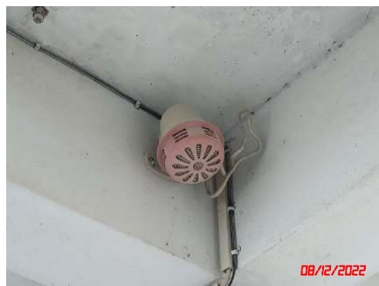
รูปที่ 8 ป้ายเตือนเวลาระเบิด และเครื่องส่งสัญญาณเสียงเตือนก่อนการระเบิด
